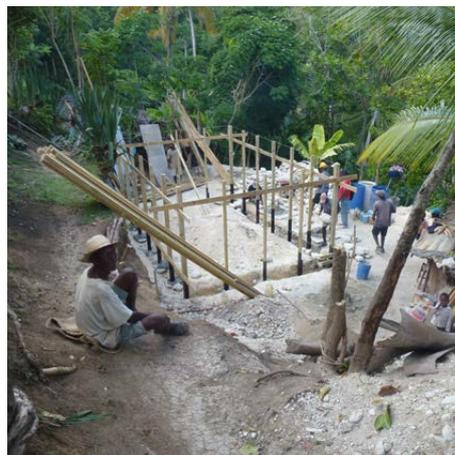
Chantier: Maison à structure bois et remplissage des murs en roche
