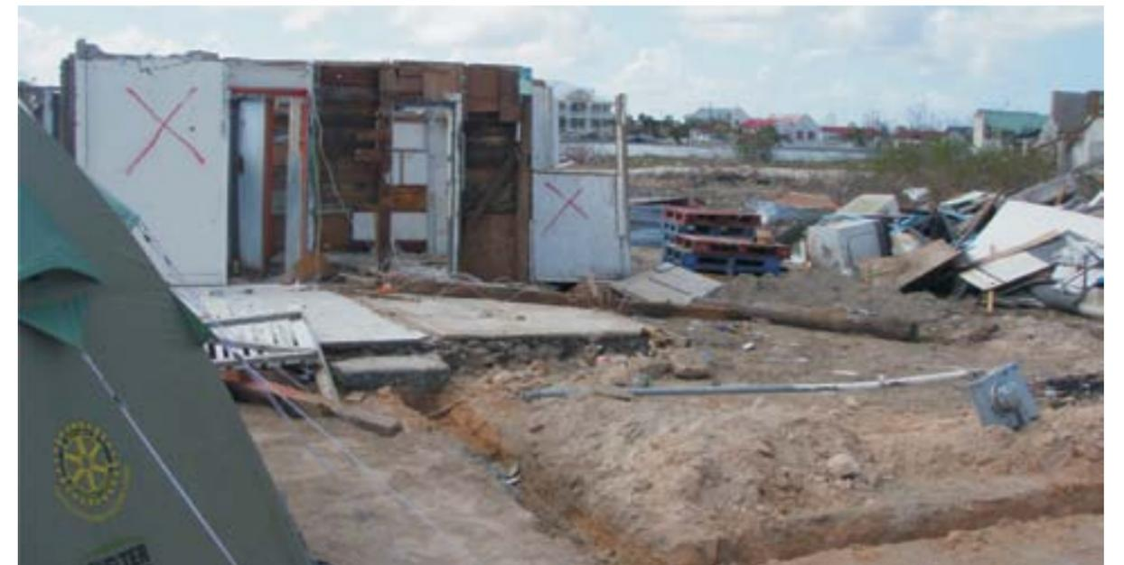
Débris type post-cyclone : un toit arraché par le vent et des débris répandus sur toute la zone suite à un cyclone sur l'île Turques et Caïques en 2008. Source : MSB et Anttilator
